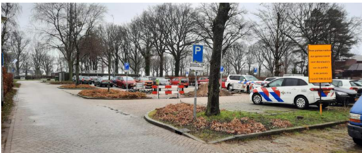
Figuur 3: Werkzaamheden sectie 3 op zaterdag 18-02-2023
