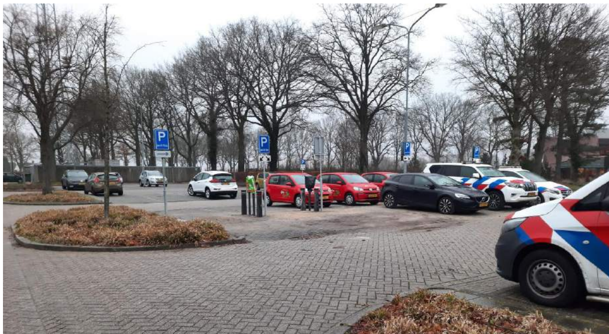
Figuur 4: Werkzaamheden gereed in sectie 3 op dinsdag 21-02-2023
